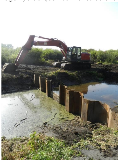
Restauration d'un ouvrage hydraulique à l'Etang des Nonnettes (Marchiennes)
