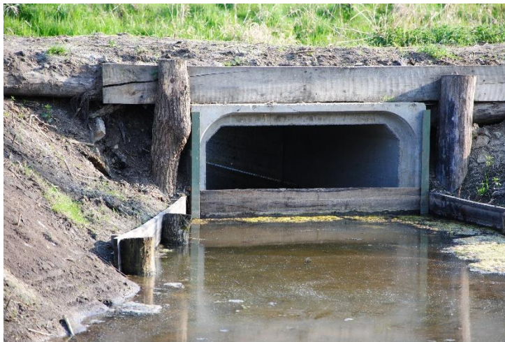
Entretien d'un ouvrage hydraulique visant à restaurer une zone de frayère
